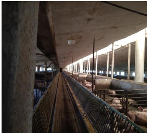
Obrázek č. 5: Interiér objektu chovu prasat
