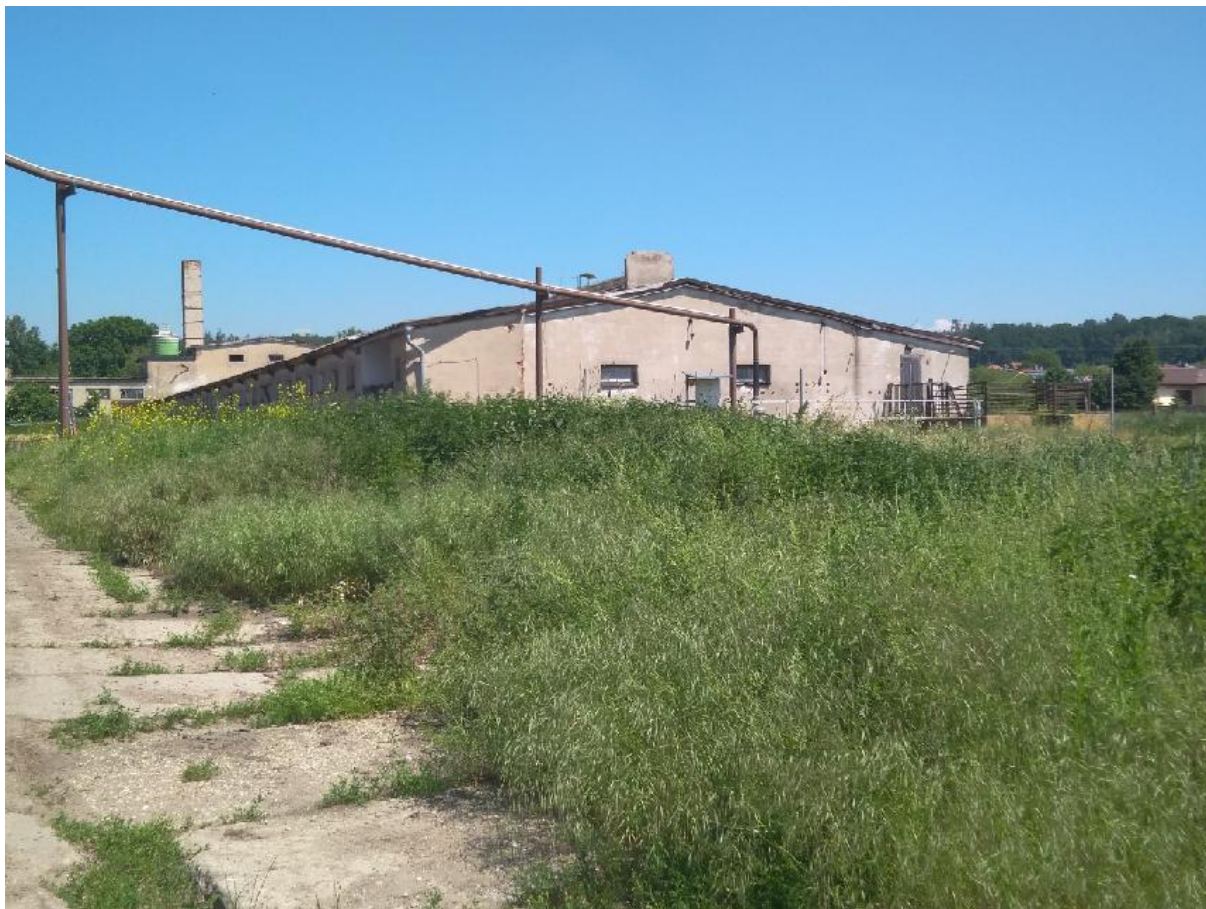
Obrázek č. 6: Objekt chovu prasat Gigant – pohled z předu. Vpravo obytná zástavba
