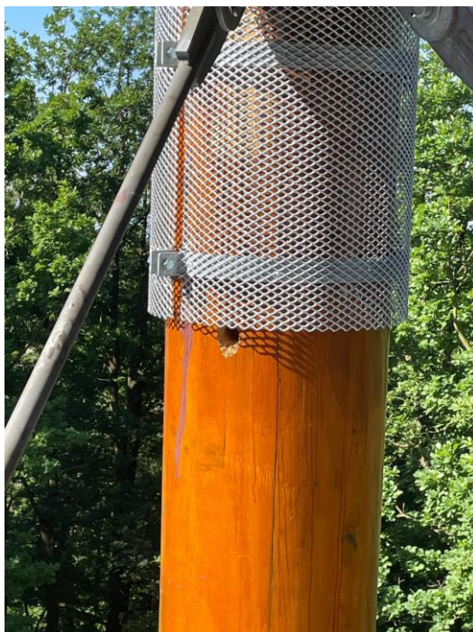
Obr. 11 - Sloup č. 2, díl B, foto zachycuje „čerstvou“ díru po napadení strakapoudem. Snímek zhotovil zákazník 14.06.2021
