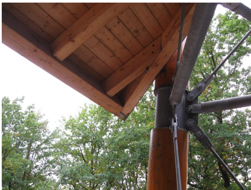
Obr. 19 - Krov domečku rozhledny, foto zachycuje typický stav krovu domečku - s výjimkou okraje a rohu (římsy) má povrch přirozenou barvu a nátěr je zachovalý. Snímek zhotovila zkušebna 07.10.2021
