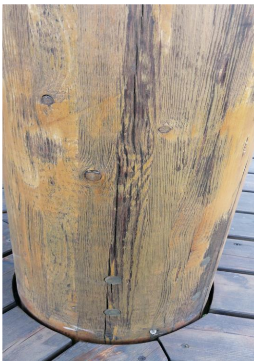
Obr. 13 - Současný stav povrchu sloupů na vyhlídkové plošině rozhledny. Snímek zhotovila zkušebna 07.10.2021
